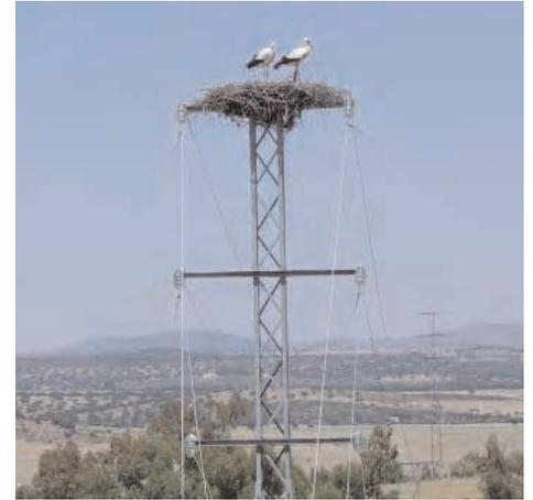
Para evitar esas muertes se procede a la señalización de los conductores, a la modificación del diseño de los apoyos o a la aplicación de otras soluciones técnicas.
